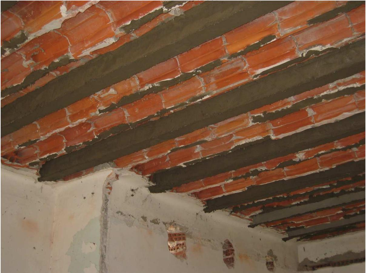
**VISTA DI UN SOLAIO CON RINFORZO DI UN TRAVETTO SU TRE**
